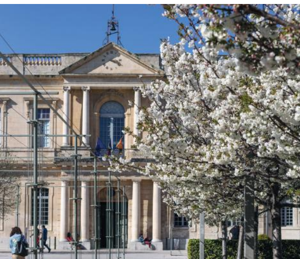
↑ Campus Hannah Arendt bâtiment Nord
